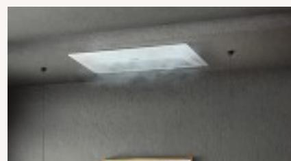
\*135 mm è l'altezza dell'unità fino al pannello dal soffitto. 145 mm è l'altezza compresa il pannello dal soffitto. I modelli fino a 2,5 kW e 3,6 kW (FJM) misurano 135 mm (180 mm pannello incluso).
